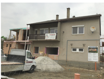
Zajlik az építkezés
